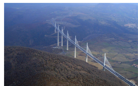
Viaduc de Millau
