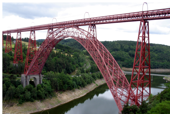
Viaduc de Garabit
